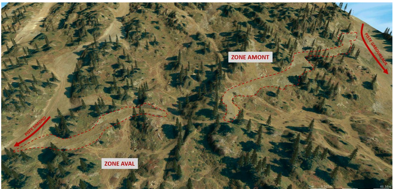
EMPRISE DES TERRASSEMENTS DU CHEMIN PISTEURS
