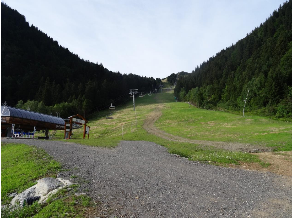
ÉVOLUTION DU PROJET DE RESTRUCTURATION DE CASSEROUSSE EN 2017
