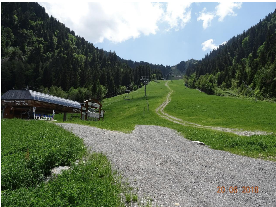
ÉVOLUTION DU PROJET DE RESTRUCTURATION DE CASSEROUSSE EN 2018
